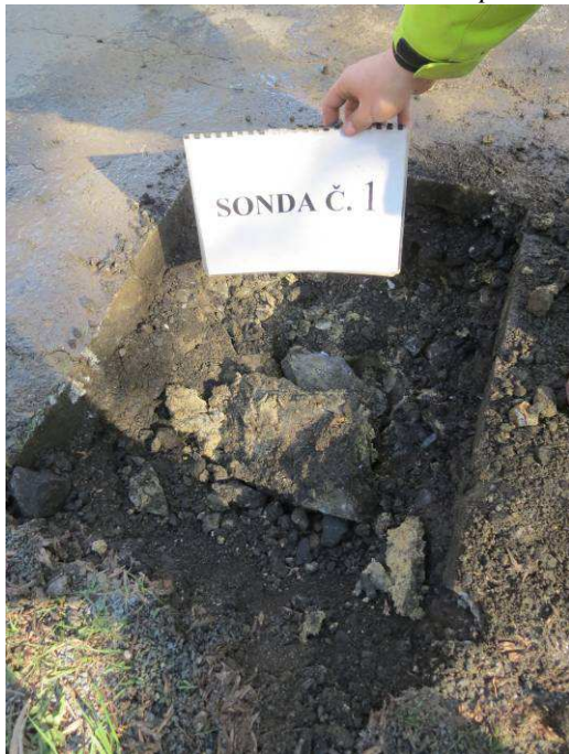
Obr.3.F Sonda č.1 – štět v úrovni zemní pláně
